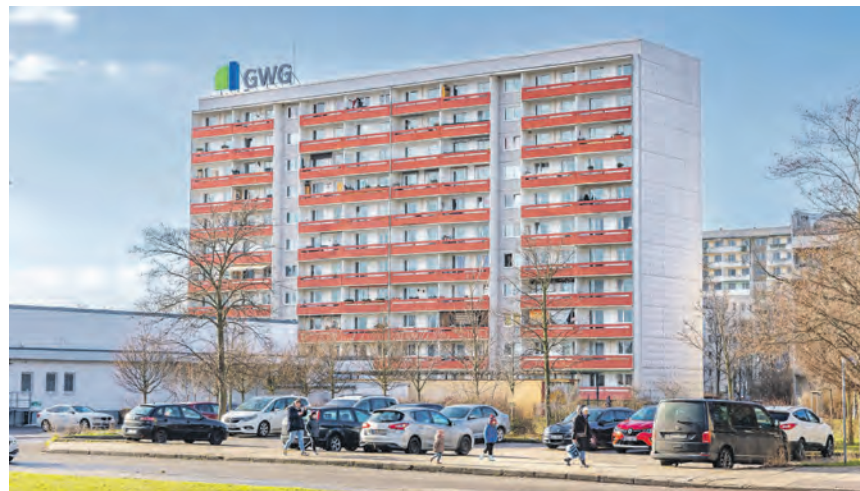
Die GWG will den Elf-Geschosser in der Hyazinthenstraße energetisch sanieren.
