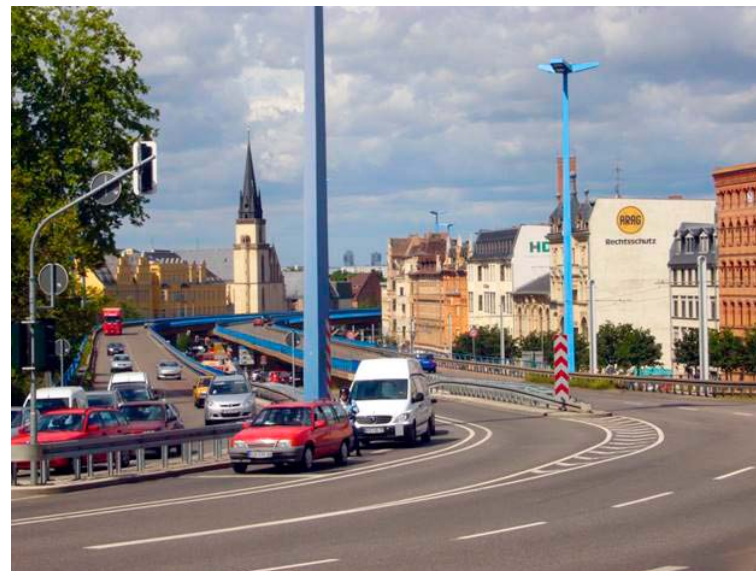
Die B80 im Stadtzentrum hat eine hohe Leistungsfähigkeit; der Verkehrsablauf ist jedoch störanfällig.
