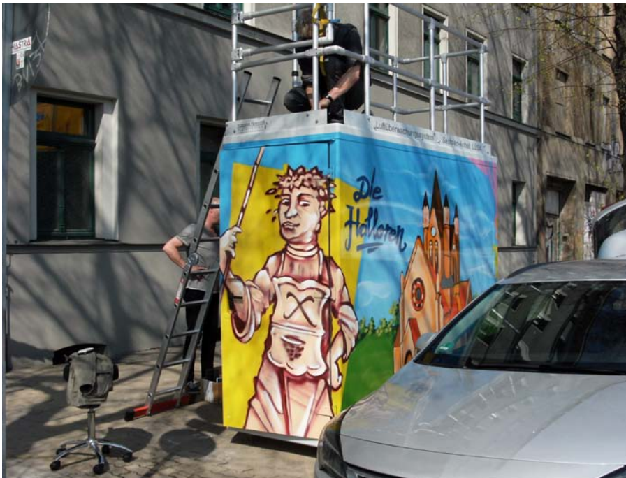
Aufstellung der neuen Luftüberwachungsstation an der Paracelsusstraße im Frühjahr 2018
