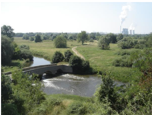
Schafbrücke über die Weiße Elster
